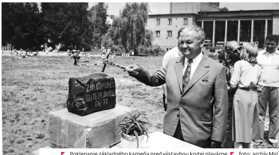
Poklepanie základného kameňa pred výstavbou krytej plavárne. foto: archív MsÚ
