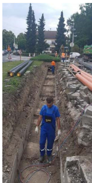
Rekonštrukcia tepelných rozvodov v meste bola najväčšou investičnou akciou v roku 2020. foto: archív MsÚ
