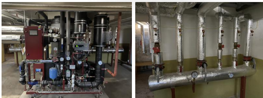
Obrázok 10. KOST a rozdeľovač ÚK
