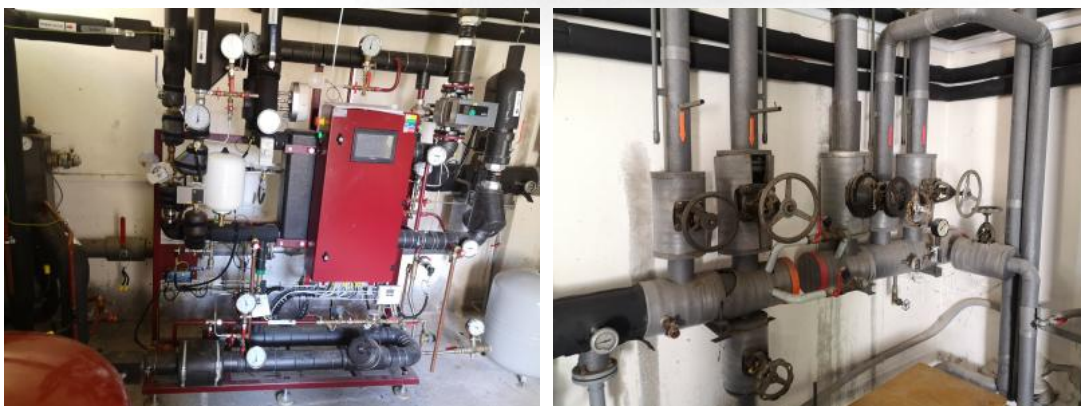
Obrázok 8. KOST a rozdeľovač ÚK
